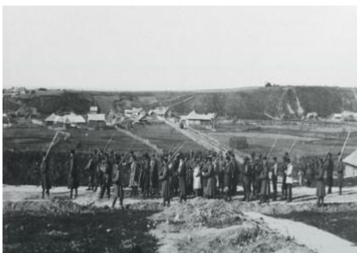
Иллюстрация 3. Переселенцы идут со строительных работ
